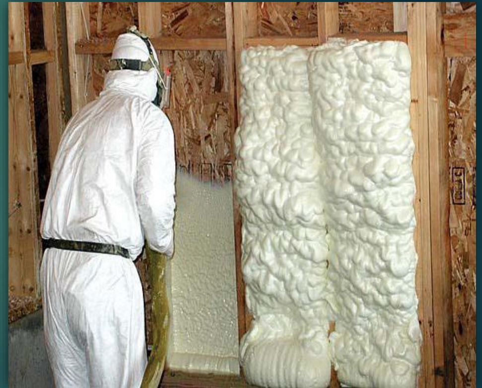
Рис. 4. Процес нанесення карбамідо-формальдегідного пінопласту (піноізолу) у порожнини стінових конструкцій
