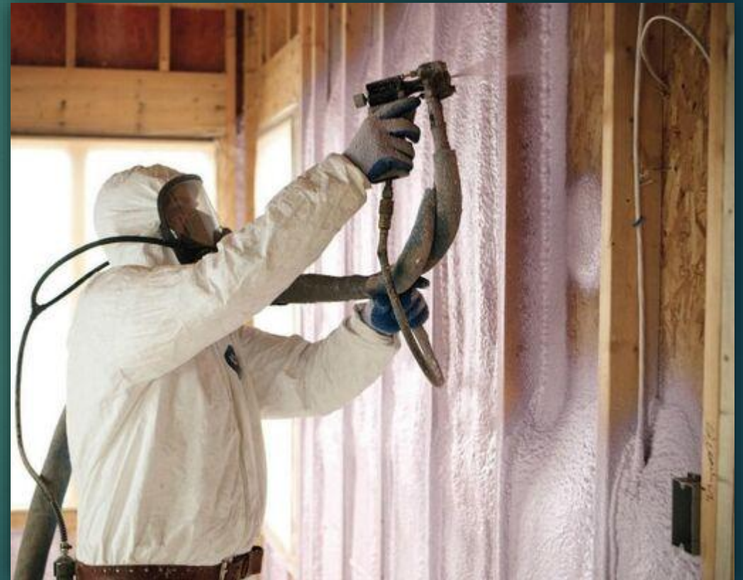
Рис. 9. Процес нанесення теплоізоляційного матеріалу методом напіння на стінові конструкції
